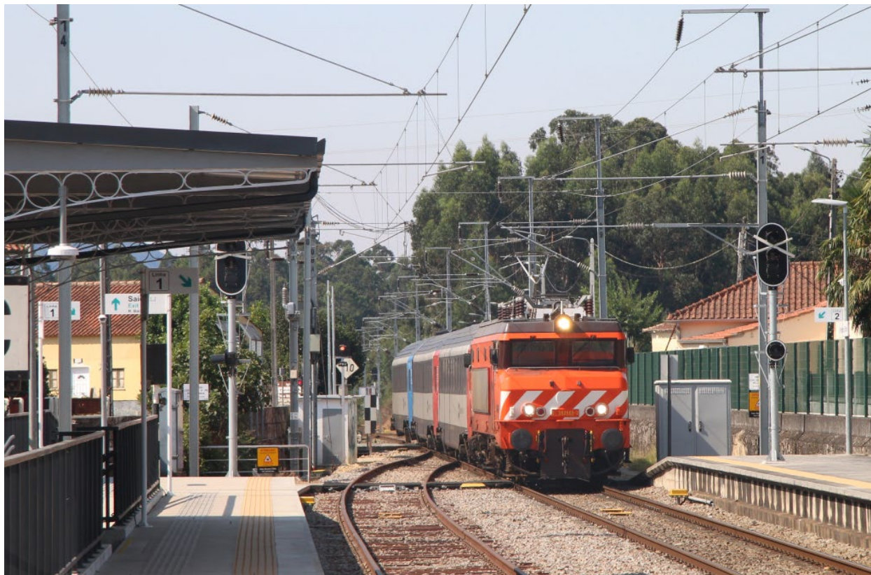
Figura 14 - Exemplo de via que converge directamente para via de circulação - diminui segurança, performance e capacidade
