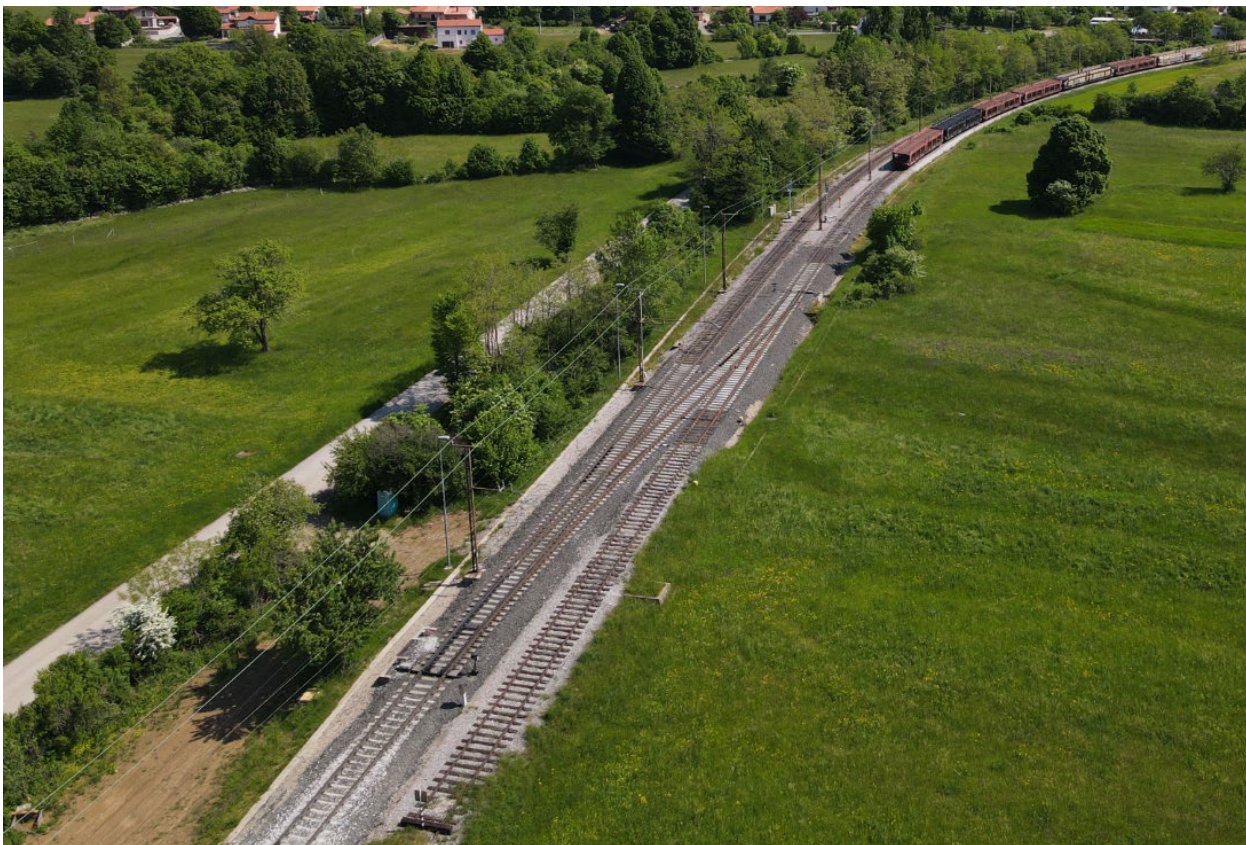
Figura 15 - Linha sem fim, dita de "escorregamento", que permite maior segurança ao comboio desviado e reduzir tempos de confirmação necessários para autorizar passagem de outro comboio em sentido contrário.
