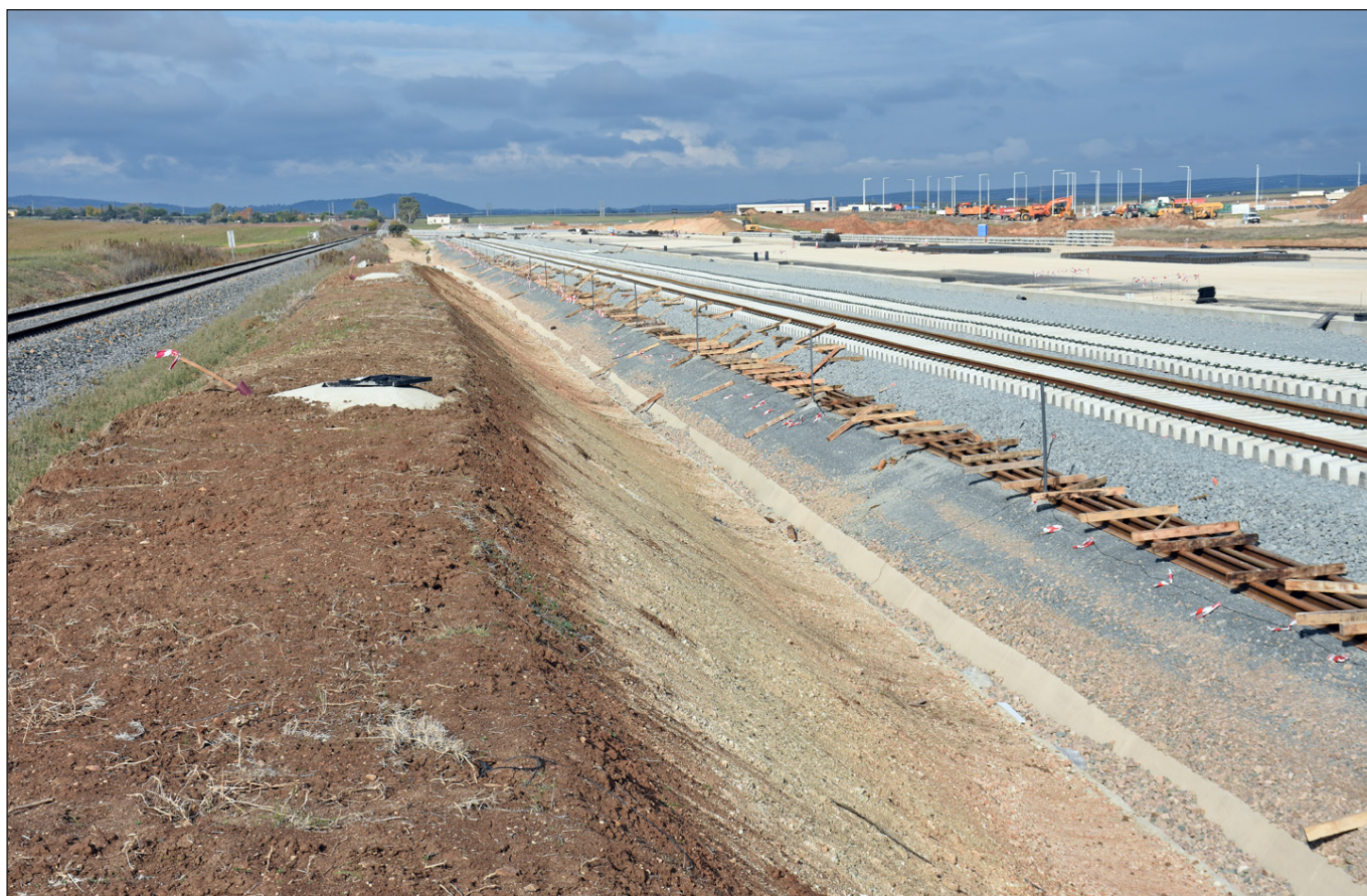
Vista panorâmica geral da área destinada à plataforma logística, com a colocação dos primeiros carris em primeiro plano. À esquerda, linha geral Badajoz - Elvas. 21 de Novembro de 2021.
